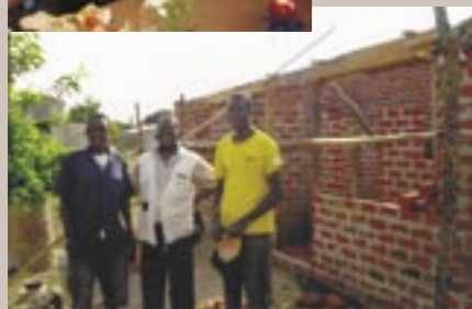
Her er huset til Francisco under byggingen. Francisco (helt til høyre) er nå 18 år og ser fram til å få et hus for seg selv. I midten ser vi pastor Madeira, og til venstre han som setter opp huset. Foto: Lars Blystad
